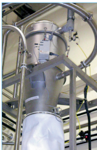
Receptor de la Serie 2400 transportando sal
